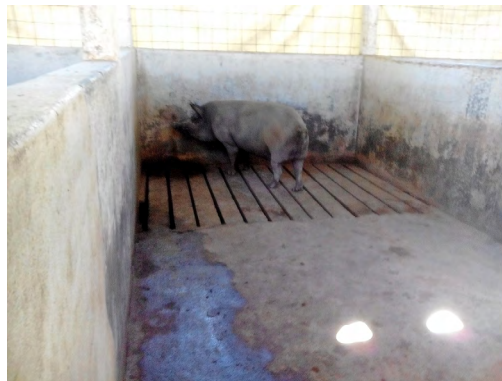
FIGURA XI-4. Corral con piso rayado y slat en área húmeda. (Silva, 2017).
